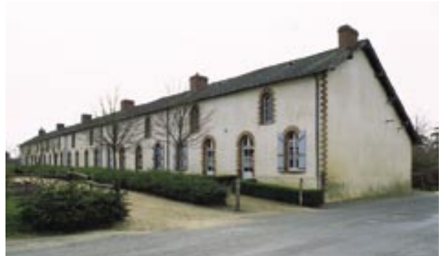
La première « barre » de logements pour les ouvriers des ardoisières de Misengrain (Combrée).
