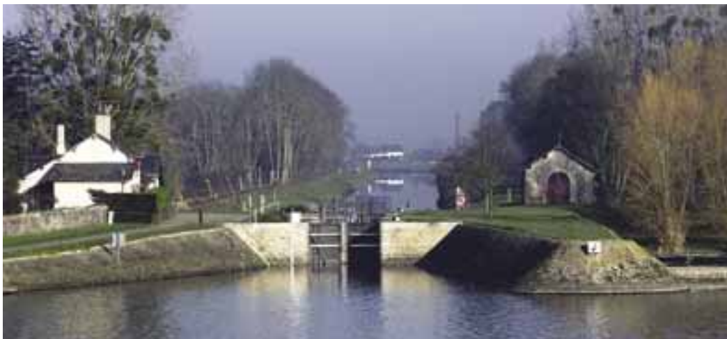
Vue de l'écluse de Grez-Neuville (1847-1872).
